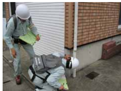
基礎のクラックを目視により調査
