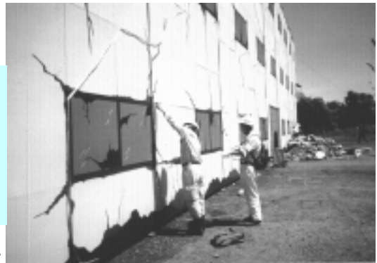
仮設 RC造を調査する。
