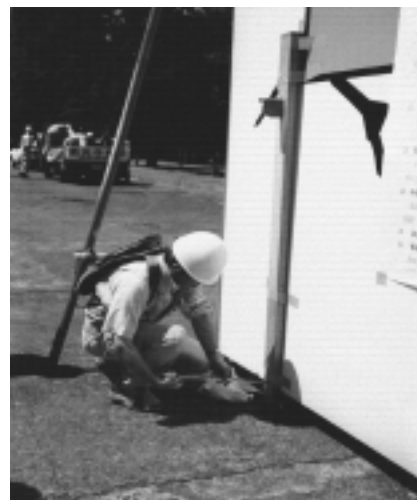
下げ振りで建物の 傾斜を調査する。
