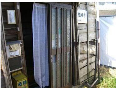
外周の窓や玄関引き戸などの建具が被害を受け使用できない状態にあるか、ガラスなどが破損しているか、破損するおそれがあるかなどの調査を目視で行います。
