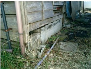
外周基礎が不同沈下し、ひび割れが生じているか、基礎と土台が遊離し、上部構造を支えられる状態になっていないかなどの調査を目視で行います。
