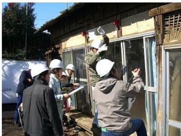
建築物の1階の傾斜が、1/60以下、1/60～1/20、1/20超のどれに当てはまるかの調査と、外壁材のひび割れ、面外に湾曲しているか、下地材から脱落しているかなどの調査を目視で行います。
