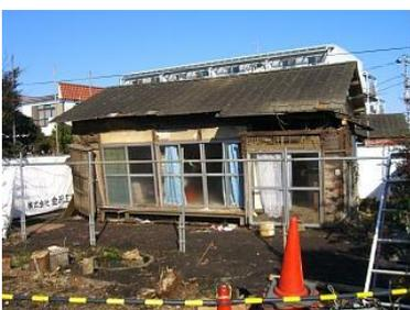
かんむり瓦、のし瓦、ひら瓦などの屋根葺き材の不陸、ずれ、破損、落下などの損傷状況の調査を目視で行います。
