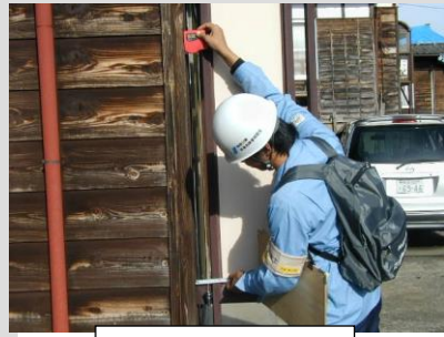
建物の傾斜の測定
