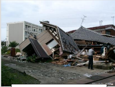
完全に倒壊した木造建築物
