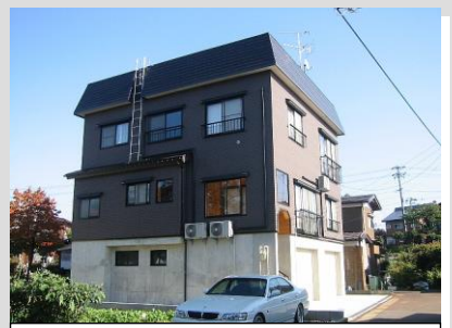
被害を受けなかった高基礎式住宅
