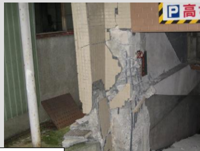
RC造建築物の被害
