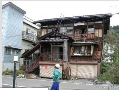
大きく傾斜した木造建築物
