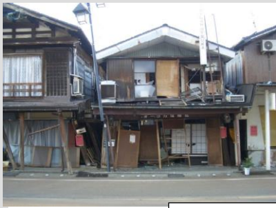
大きく傾斜した木造建築物
