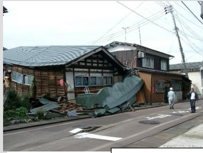
1階部分が倒壊した木造建築物
