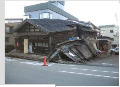
1階部分が倒壊した木造建築物
