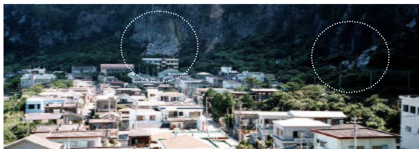
新島若郷地区（斜面の正面及び右側に崖崩れが見られる）
