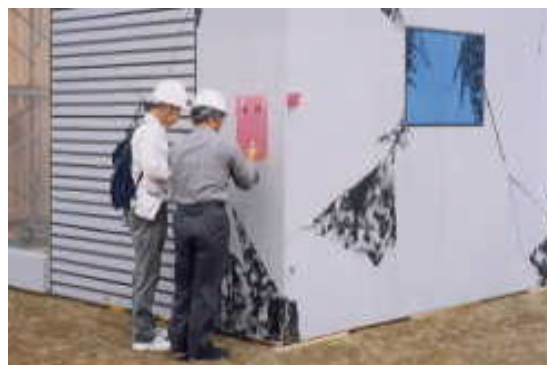
仮設RC造に危険の標識を貼付する判定士
