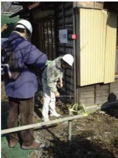
B棟の傾斜を下げ振りで測定する判定士
