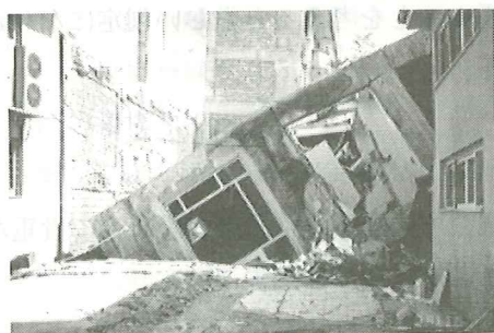
液状化で倒壊した建築物
