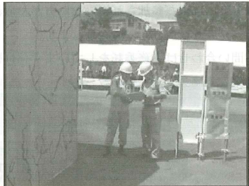
仮設木造住宅を調査する判定士
