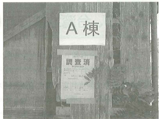
A棟に貼られた調査済の判定標識
