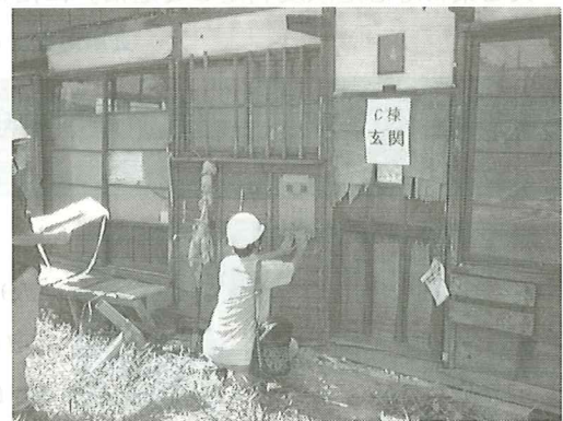
C棟に要注意の判定標識を貼る判定士
