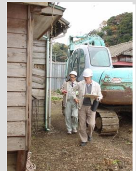
⑤ 落下危険物被害把握 (瓦,窓ガラス,外装材など)
