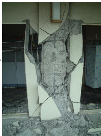
3階柱の剪断破壊
