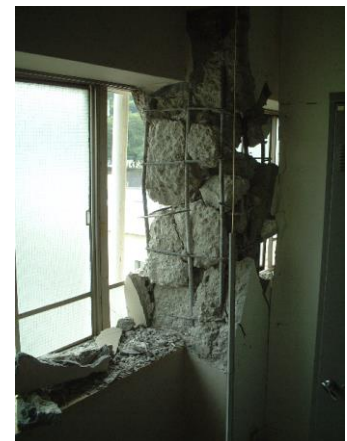
3階柱の剪断破壊
