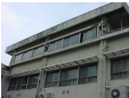
■国保病院(北棟) 鹿島台町
