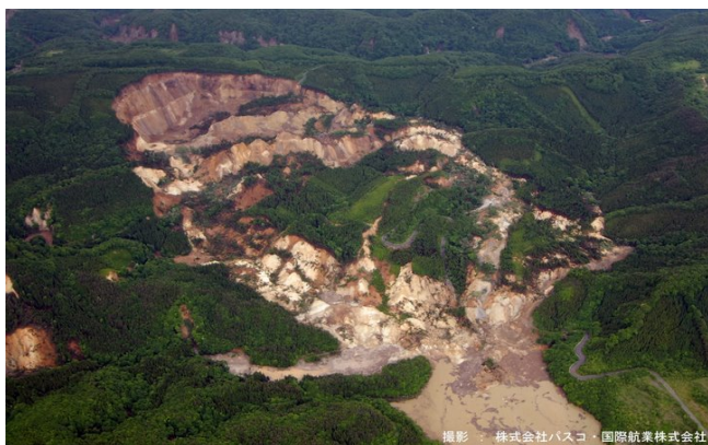
(栗駒文字地区 荒砥沢ダムの大崩落)
