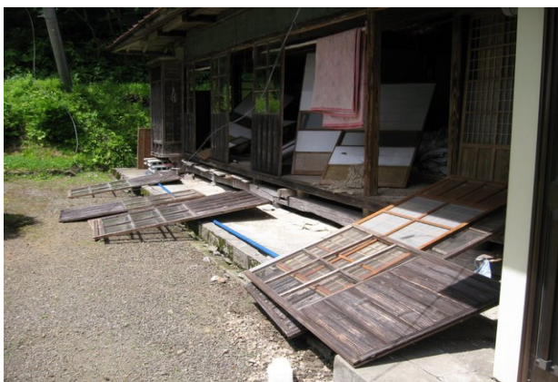
(花山地区 家屋の外観)
