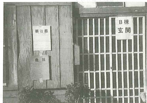
B棟に貼られた「要注意」と「危険」の判定標識
