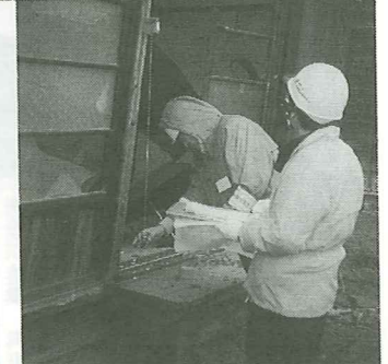
C棟の傾斜を下げ振りで測定する判定士
