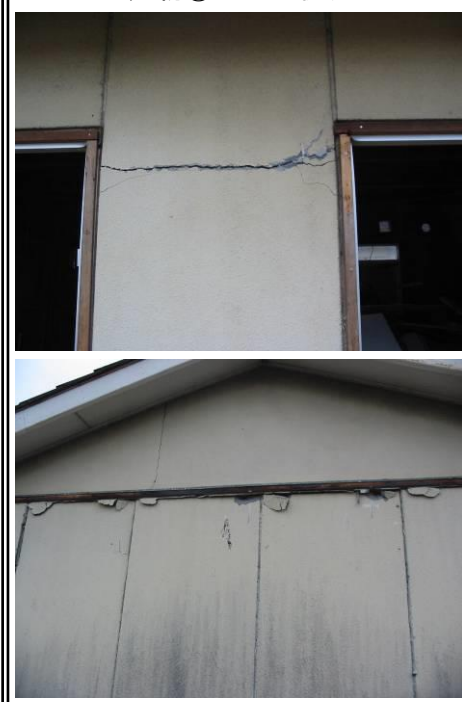
<建物②の壁の状況>
