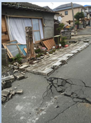
○ブロック塀の倒壊
