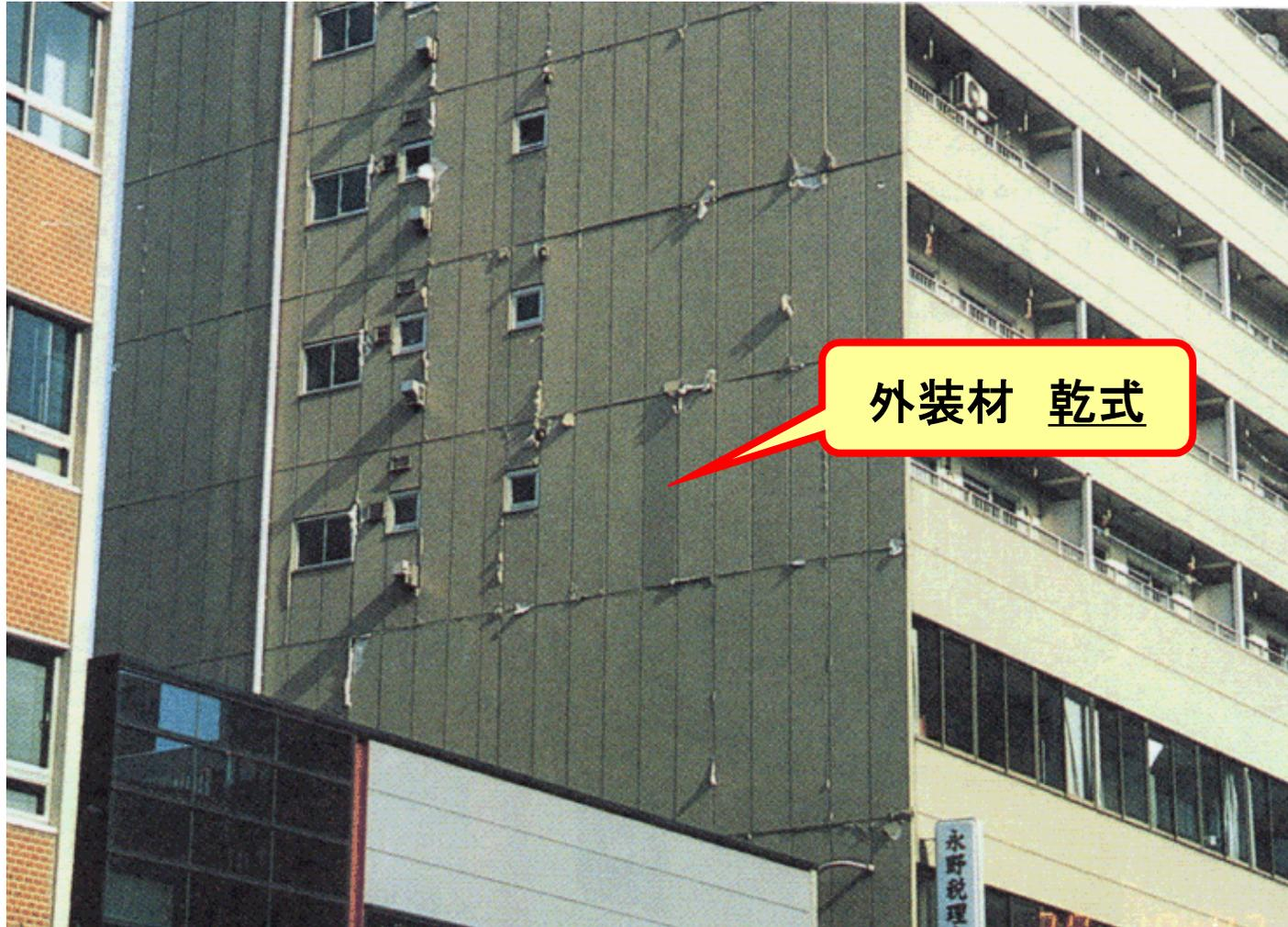
鉄骨造: ALC板の目地破損およびはらみ出し、Cランク
