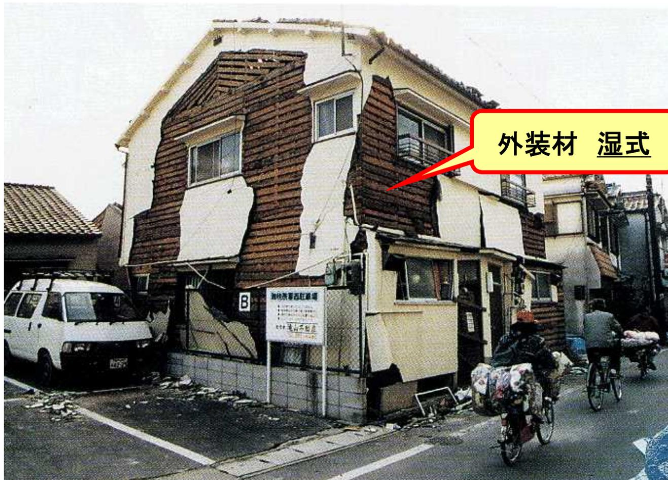
木造：外壁モルタルの剥落および落下
