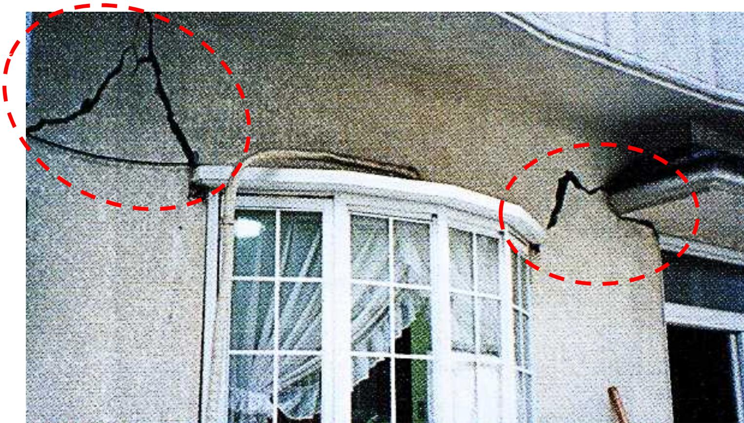
1階外壁のサッシ周りのひび割れ
