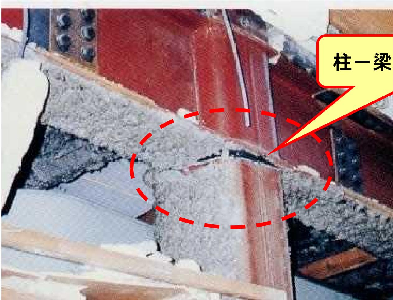
柱-梁接合部の損傷
