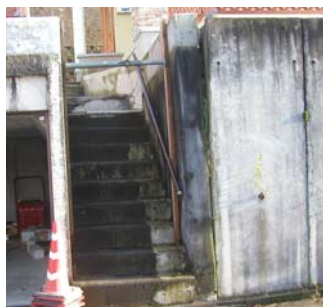
切梁による擁壁変位抑制
