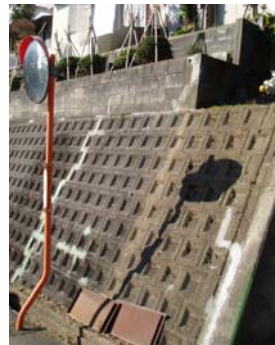
モルタル充填による亀裂の防護
