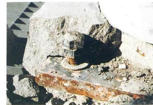
露出形柱脚のアンカーボルトの抜け出し
