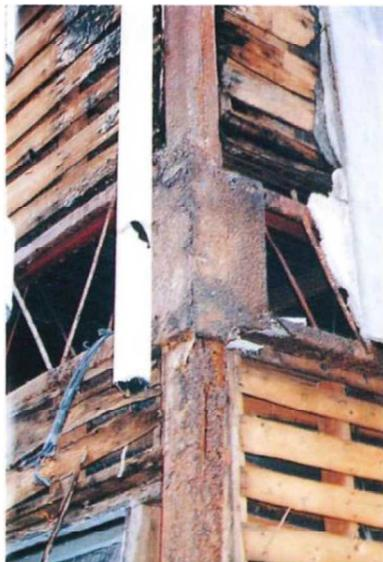
腐食が進行した鉄骨部材
