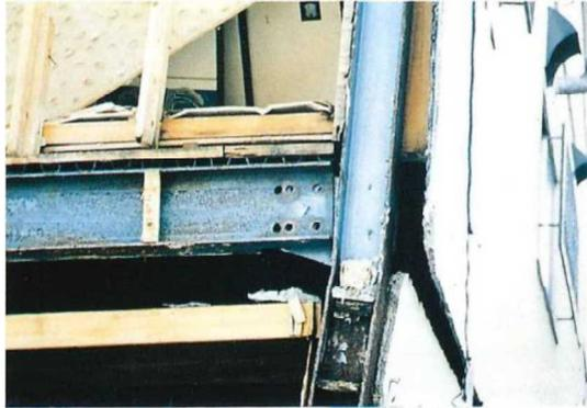
柱－梁ボルト接合部で柱が座屈し、ボルトも外れている。
