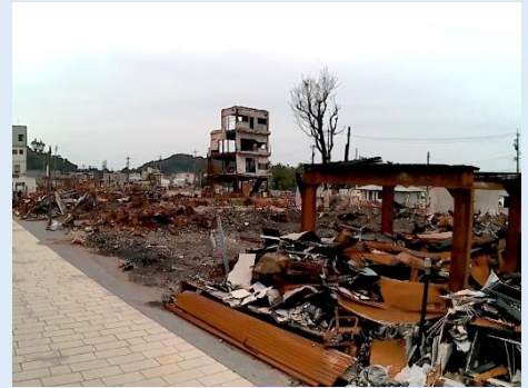
【輪島朝市通り 火災現場】
